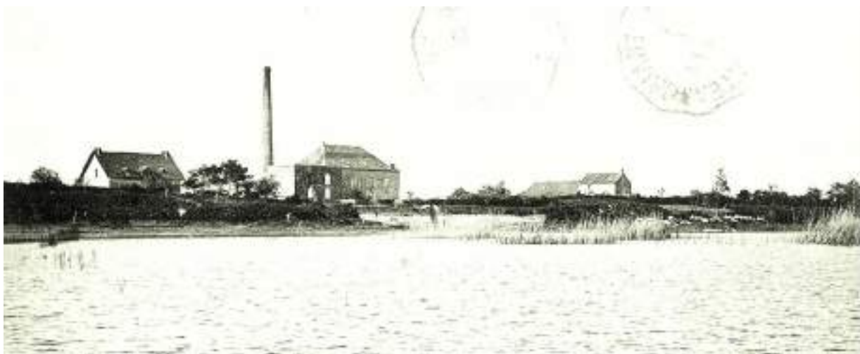
La minoterie à Beaumont construite par la famille Perraud
